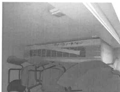
Εικόνα 26: Μονάδα fcu με βλάβη (κλειστή).
