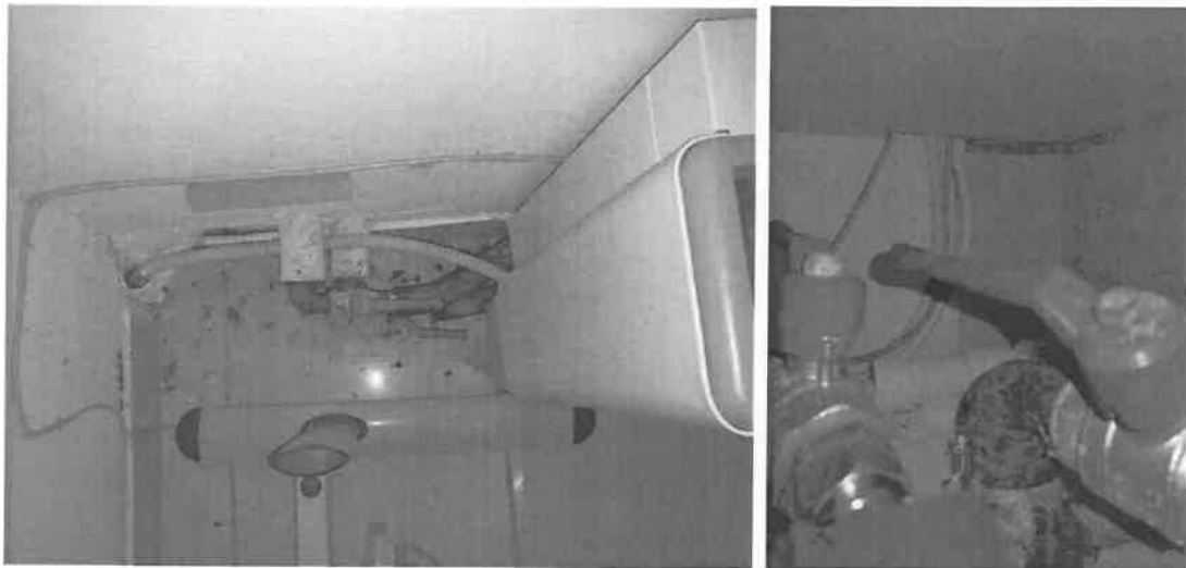
Εικόνες 22, 23: Εσωτερικά τμήματα σωληνώσεων αμόνωτα και διαβρωμένα (συνδέσεις fcu).
