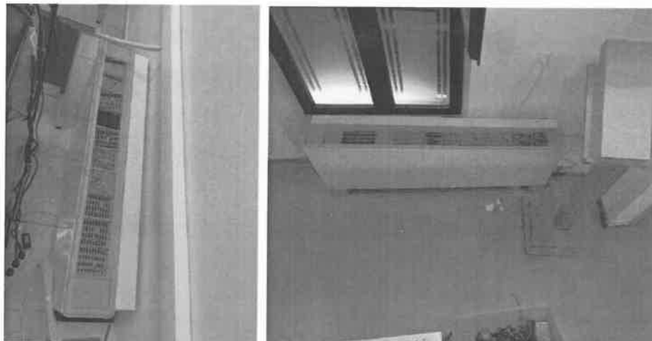
Εικόνες 24, 25: Μονάδες fcu με μικρές ζημιές στο στόμιο προσαγωγής αέρα.
