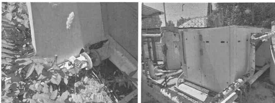
Εικόνες 12, 13: Ενδείξεις διάβρωσης σε στοιχεία σωλήνωσης (φλάντζες κλπ).
